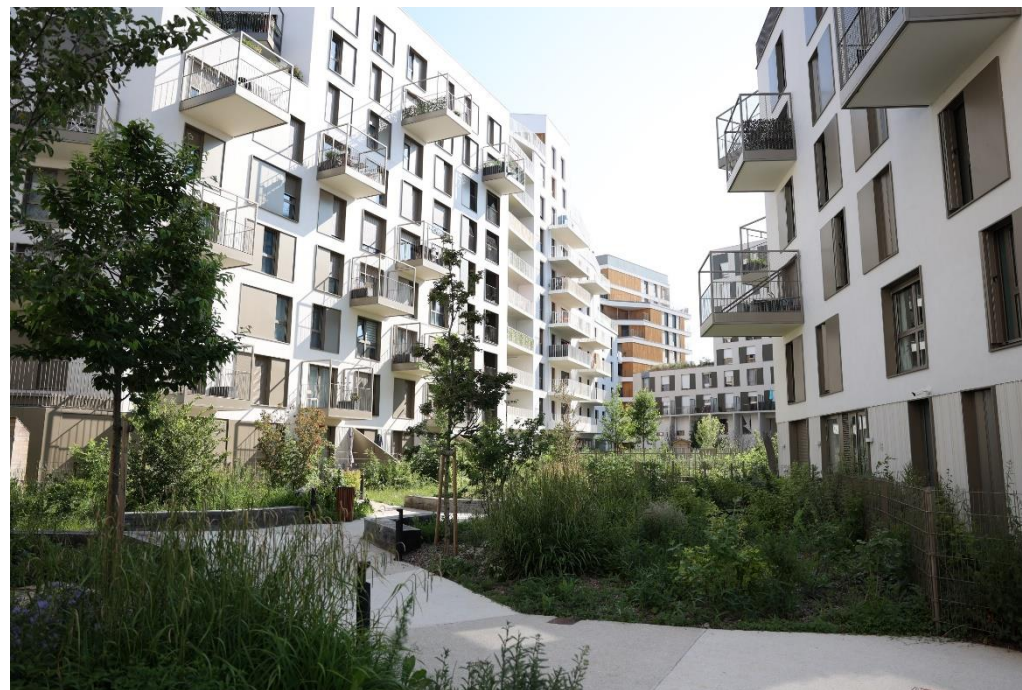
L'écoquartier des portes d'Orly
